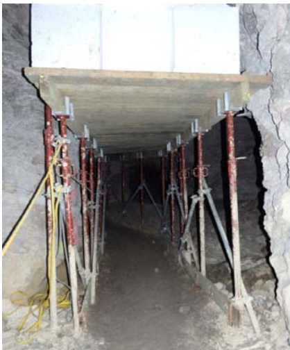
Figure 8 : soutènement provisoire
