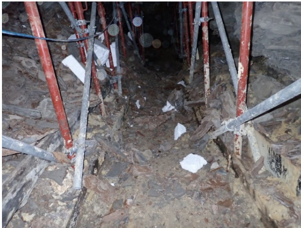
Figure 5. Chemin d'accès sous le soutènement
