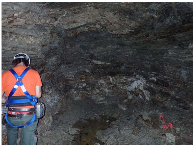
Figure 7 : Cavité au droit de l'enjeu G - Ecoulement d'eau via un ancien sondage
