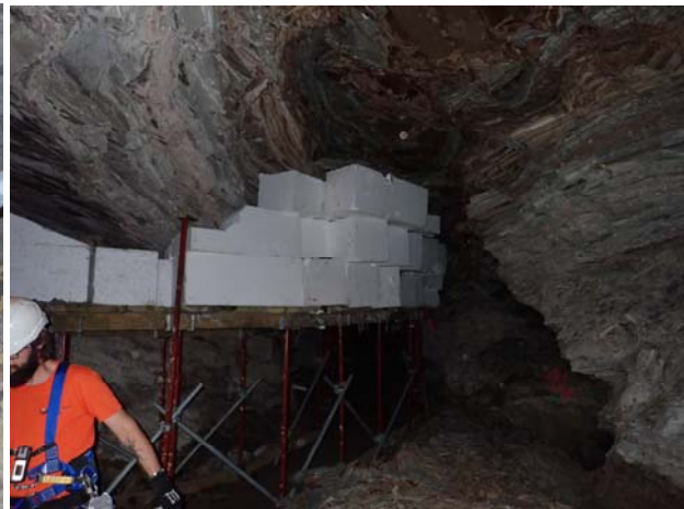
Figure 6. Chutes de toit
