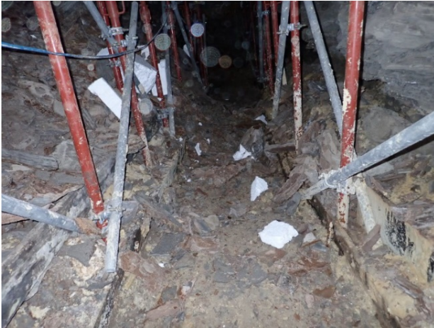
Figure 5. Chemin d'accès sous le soutènement
