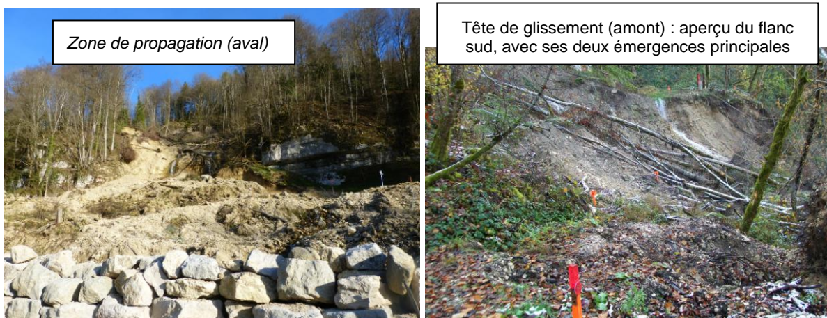
Figure 2 : Surveillance régulière du versant en application du protocole (repères topographiques, suivi qualitatif des débits d'émergence et de l'état de saturation des terrains, suivi pluviométrique) conçu pour conserver au maximum la circulation routière en fond de haute vallée du Doubs
