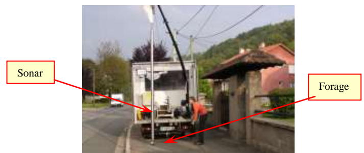
Figure 7 : Inspection par sonar d'une cavité
