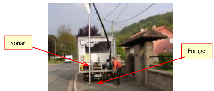
Figure 7 : Inspection par sonar d'une cavité
