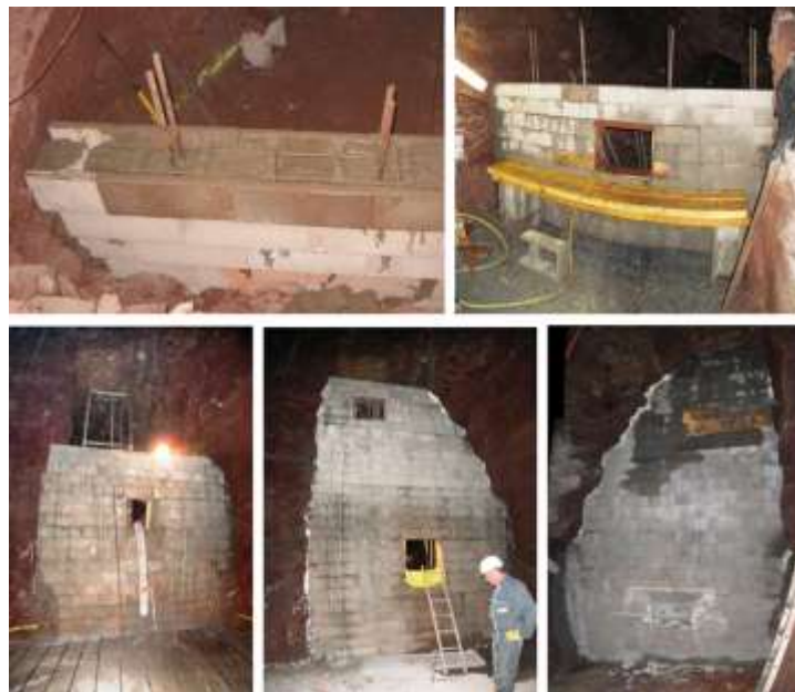
Figure 9 : Montage des murs de confinement
