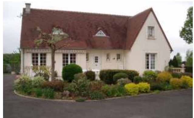
Figure 6 : Vue du pavillon à mettre en sécurité
