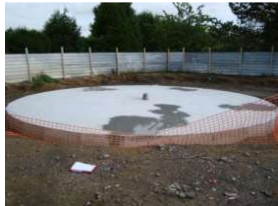
Figure 13 – Dalle fermeture puits terminée
