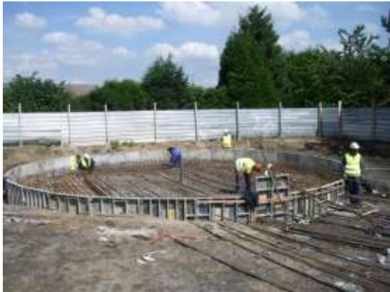
Figure 12 – Mise en œuvre coffrage ferrailage
